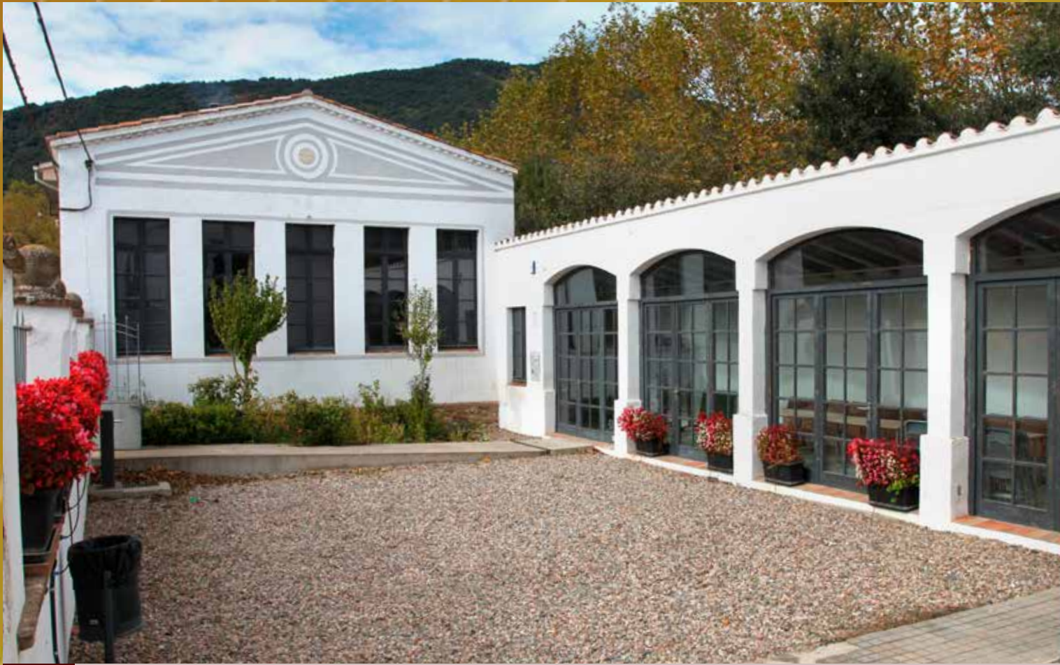
Escola d’El Pasteral, en l’actualitat magatzem municipal. D’estil noucentista, projectada per l’arquitecte Isidre Bosch i Bataller. Destaca la galeria que connecta la classe amb l’habitatge del mestre, amb quatre arcades d’arc carpanell rebaixant
